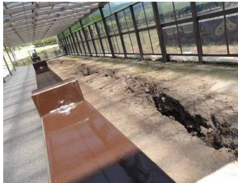
地表地震断層
