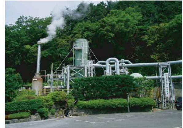
地熱発電は、地下から取り出した蒸気を使ってタービンを回して電気を作ります。地熱発電は地面の下の蒸気を使うので、火力発電や原子力発電とは違って、石油やウランといった燃料を外国から輸入する必要がありません。また、二酸化炭素や放射性廃棄物といった地球に有害とされる物を出さないので大きな特徴です。しかし、地熱活動の盛んな場所でしか行ないので、日本では九州や東北などの地熱地帯で発電が行われています。
