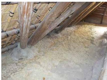
(湯の花製造の) 作業は、湯の花小屋作りと小屋の内部で湯の花を結晶化させる作業に大きく分けられる。湯の花小屋作りは、噴気を通した小屋床うえに、わらや茅で屋根を葺いたもので、内部は噴気が一定の強さでまんべんなく噴き出し、温湿度を一定に保つことで、湯の花の結晶を作り出している。
