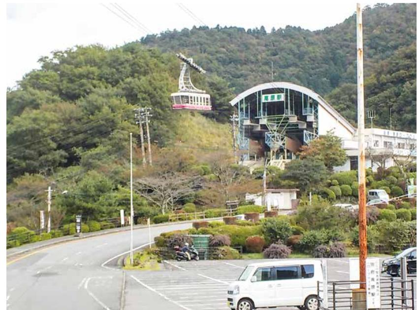
別府ロープウェイは昭和37（1962）年12月に開業し、101名乗りの大型ゴンドラを有する九州最大級のロープウェイです。線路長は1,816m、線路高低差792.5mの急勾配を約10分で運行しています。
