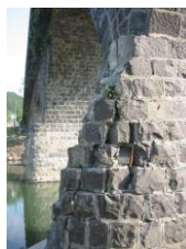
損傷した橋脚と流失した欄干（馬溪橋）
