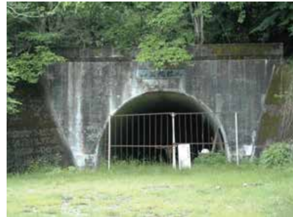
旭鉱山の坑口
