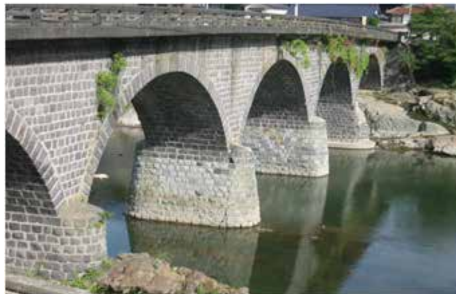
上流側より見る5連石造アーチ橋の馬溪橋
