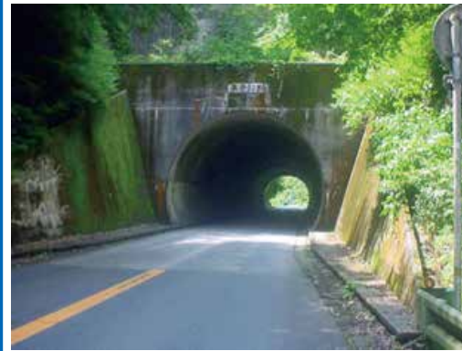
鹿倉(かのくら)トンネル
