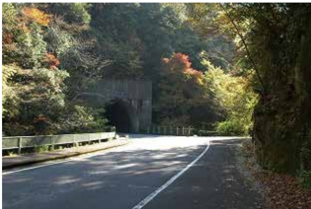
錦雲峡トンネル
