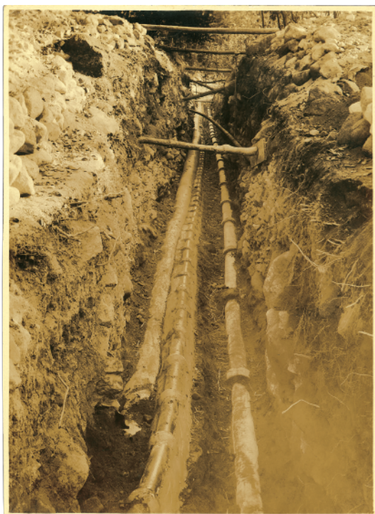
温泉引湯工事。 左が保温工事を施した陶管。 右は冷水を引用するヒューム管
