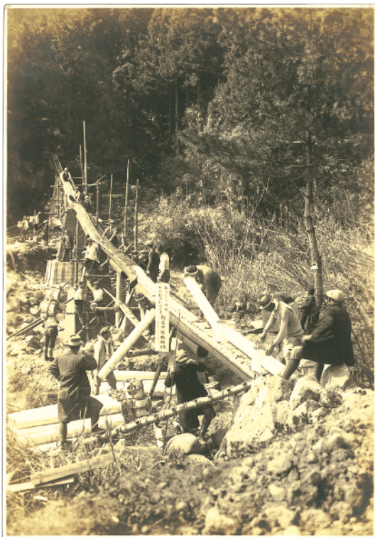
大規模な引湯工事の現場
